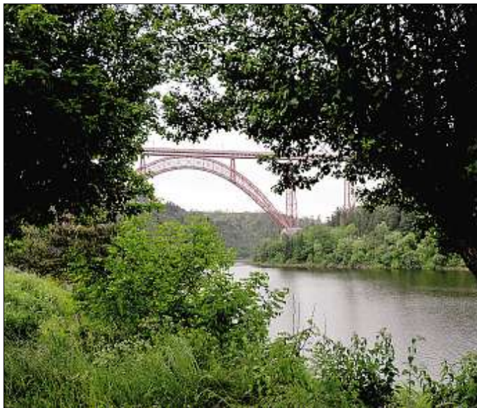
NOUVELLE JEUNESSE. Le viaduc, d'un rouge "Gauguin" depuis 1992.
